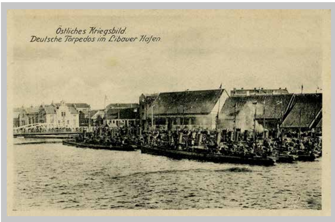
Tyska torpedbåtar i Libau i Lettland, numera Liepāja. Tyskarna ockuperar staden den 7/5 1915 och blir dess viktigaste stödjepunkt för krigföringen i östra Östersjön. Ofrankerat vykort. Förlag: Georg Stilke, Berlin.
